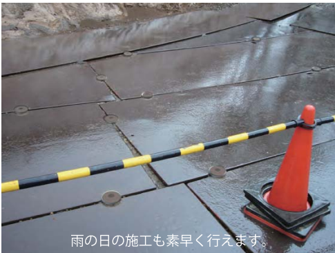
ダブルプレートにより平坦に連結可能。
